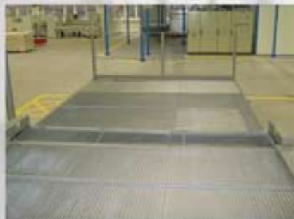
Pohled na výchozí stav rampy
